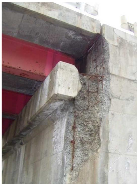
写真-1. 1 凍結抑制剤によりスケーリング劣化した橋台
