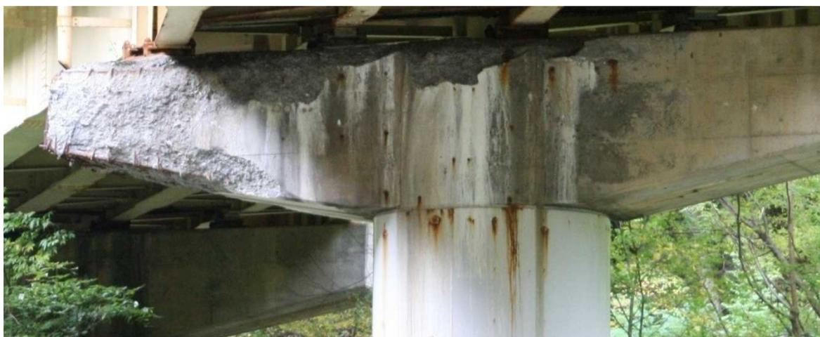
写真-1. 2 凍結抑制剤によりスケーリング劣化した橋脚
